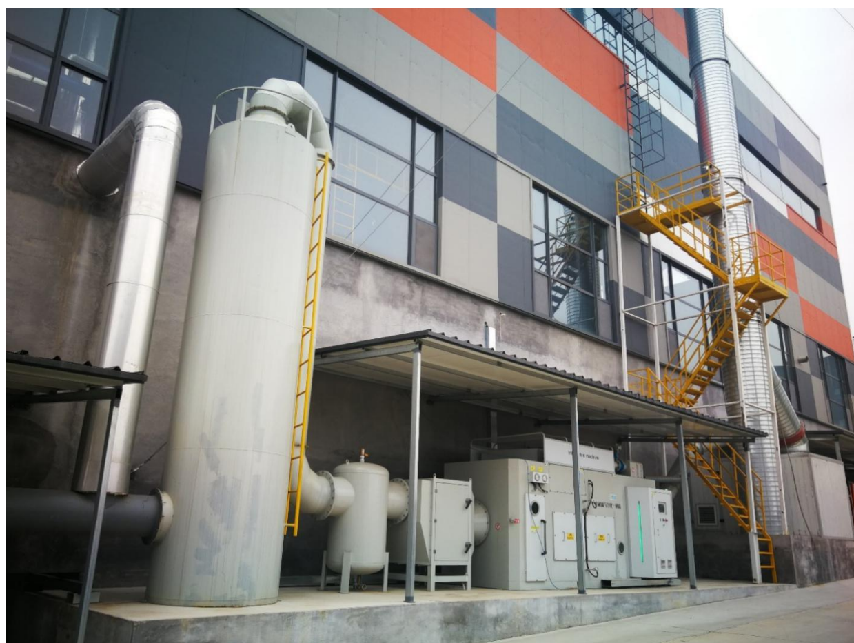
水喷淋+活性炭+多级过滤+热脱附+15 米排气筒
